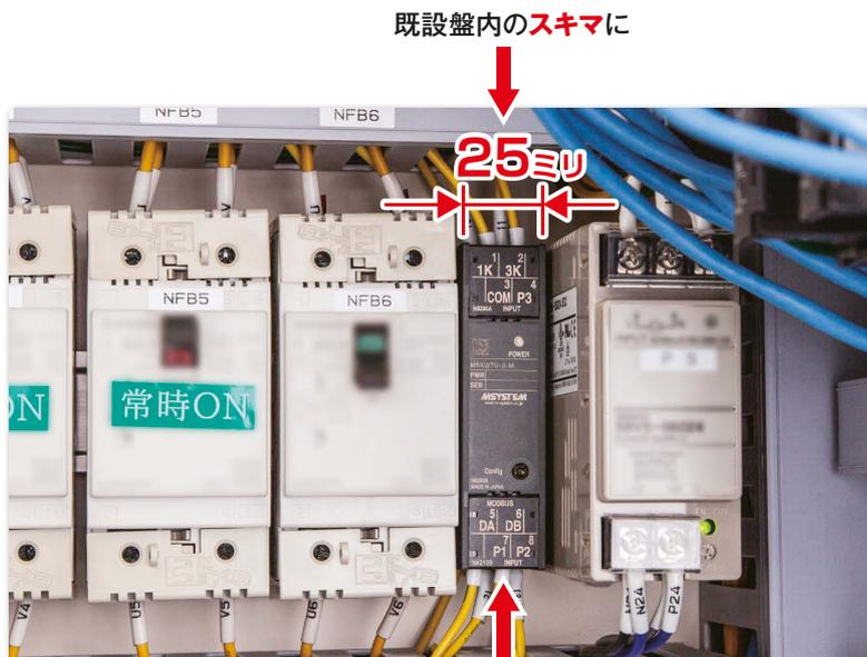
電力マルチ変換器を容易に後付けできます。
