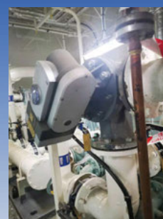
机房的电动温控阀（三通阀） 以上图片，由大连顺天兴达特种阀门有限公司提供
