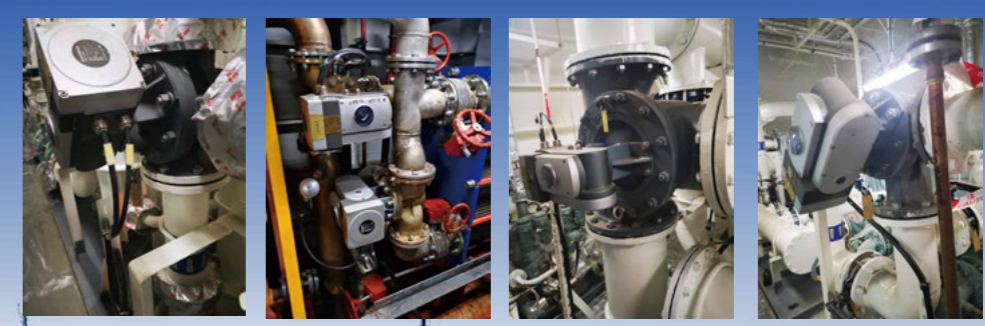
机房的电动温控阀（三通阀）以上图片，由大连顺天兴达特种阀门有限公司提供
