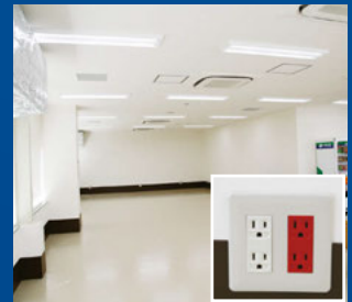
3층 정전 대피 구역 (적색 콘센트는 정전 시에도 사용 가능)
