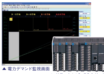
図2 デマンド監視画面とリモートI/O
