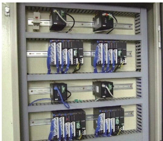
図2 盤内に設置されたWebロガーとリモートI/O R3シリーズ
