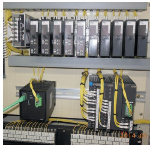
システム立ち上げ時の動作確認の際に、クライアントノートPCを現場へ持ち込み、エム・システム技研のコンフィギュレータソフト（形式：PMCFG）を利用して、現場側計測値とPC上の数値の一致を手間を掛けずに確認することができました。
