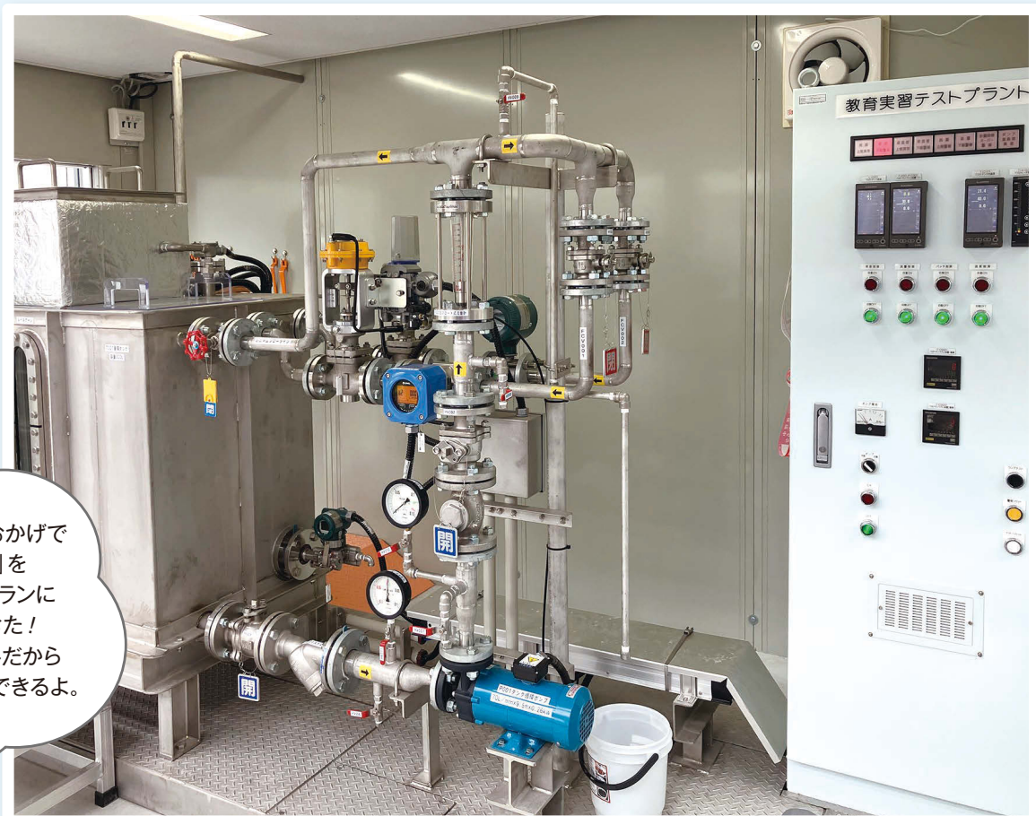
プラントレット外観
