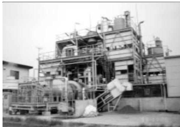
図1 ごみ焼却灰溶融石材化実証プラント
