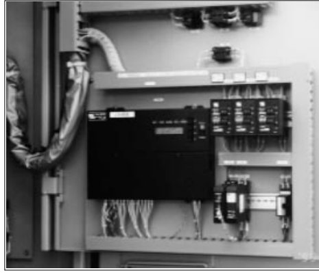
図2 中継ポンプ場の現場盤(左)と現場盤内に収納されている「テレロガー」(形式 TLX)(右) 通報されるようになっていきます。
