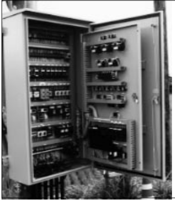
図2 中継ポンプ場の現場盤(左)と現場盤内に収納されている「テレロガー」(形式 TLX)(右) 通報されるようになっていきます。
