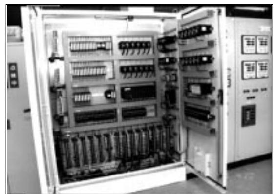
図4 MsysNetを取り付けた制御盤内部
