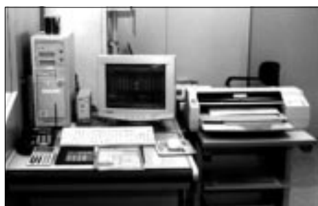
図2 機械室に置かれたオペレータズユニット
