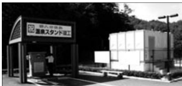
図1 温泉スタンド(温泉配湯所)。右側の建屋内に現場盤が入っている
