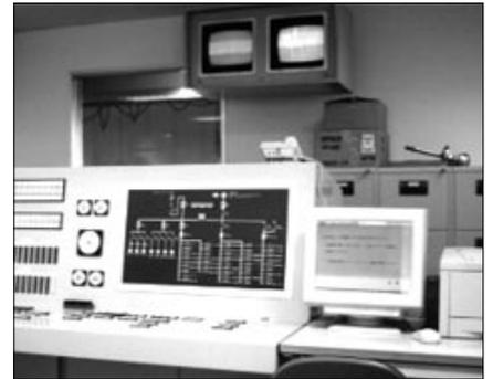
図4 監視室盤とメンテナンス用パソコン。ディスプレイ画面には、遠隔操作が終了したときのメッセージが表示されている
