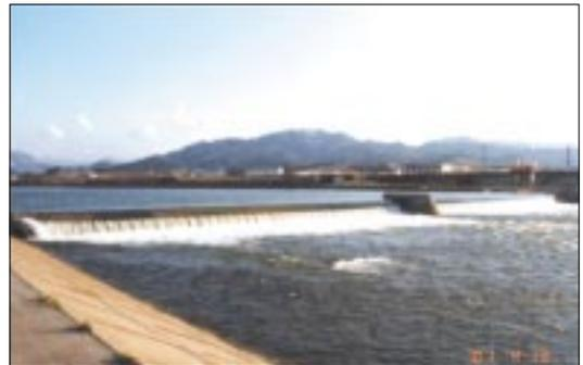
図1 平川第2頭首工。頭首工で河川の水を堰き止めて、灌漑用水を取水する
