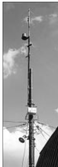
図2 浄水場にある無線LANのアンテナ
