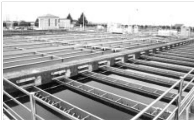
図2 西谷浄水場の横流式沈殿池
