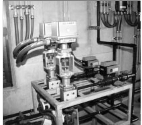
図5 次亜塩素酸ナトリウムの注入制御に採用された「サーボトップ」(形式:PSN1)
