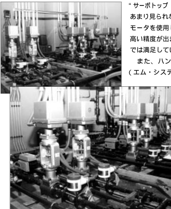
図4 凝集剤(PAC)の注入制御に採用された「サーボトップ」(形式:PSN1)と大変便利で
