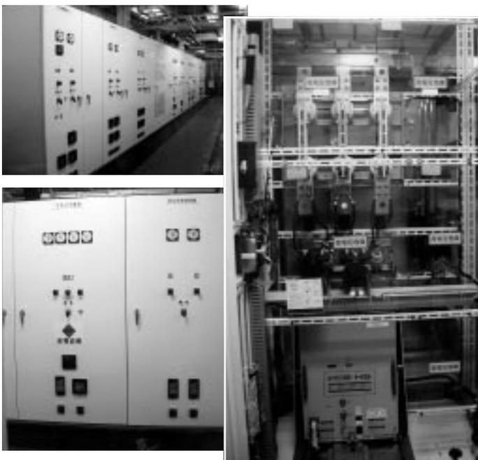
図6 総合変電所にある高圧配電盤とその内部
