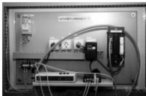
図4 各変電所の盤内にある“PLCインタフェース”(形式:70LE)とハブ(HUB)
