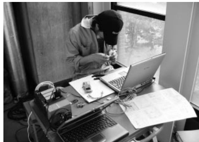
現場での PLC 調整作業の様子
