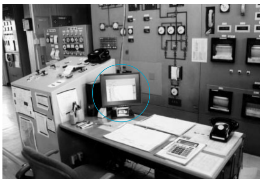
図3 机上に置かれたPCレコーダ用の液晶ディスプレイ(大島水源センター)
