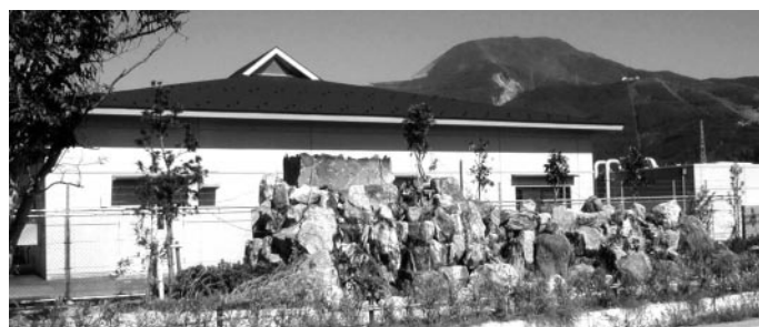
図2 膜ろ過設備を導入した本市場浄水場。右後ろに見えるのが伊吹山
