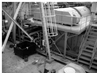
図2 碓井ポンプ場
