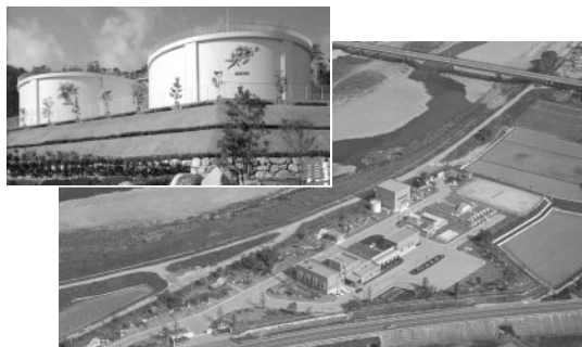
図2 千代川浄水場
